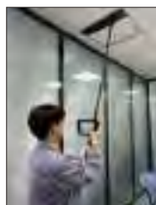
ispezione dei condotti a soffitto
